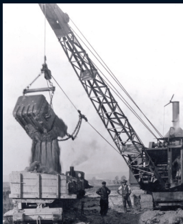
> 1926 : Dragline à vapeur Type 12 sur chenilles. A Type 12 steam-powered track-mounted dragline excavator.
