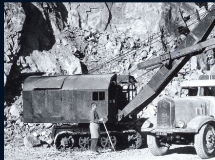
> 1938 : Pelle TR 60 - Nouvelle génération de pelles (Commandes pneumatiques, transmissions entièrement par engrenages sous carters). The TR 60 shovel - a new generation of shovels (with pneumatic controls, and all transmission through encased gears).
