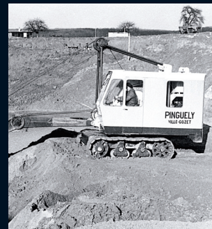
> 1956 : Pelle VG 50 - Nouvelle génération de pelles à moteur transversal. The VG 50 shovel - a new generation of shovels with transversally mounted motors.
