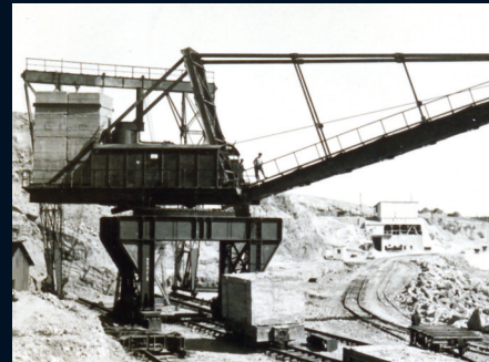
> 1920 : Pinguely emporte un marché important pour la fourniture de grues destinées à l'aménagement de ports au Maroc (Safi, Casablanca). Pinguely breaks into an important market to provide cranes for assembly in the ports of Morocco (Safi, Casablanca)
