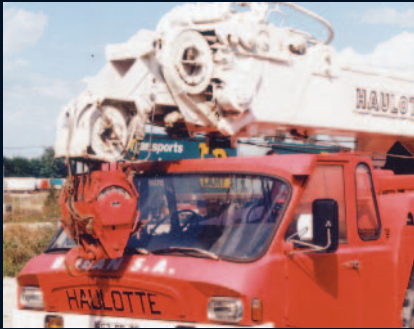
> 1972 : GB 18 - 1ère "City Crane" au monde : vitesse élevée de déplacement, mise en œuvre rapide et une cabine élévatrie. The GB 18 - the world's first "City Crane": high moving speeds, rapid deployment and a cabin raised by hydraulic jacks.
