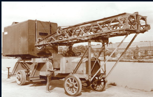
> 1930 : Grue sur porteur GR 20 conçu par la société Haulotte. AGR 20 vehicle-mounted crane, designed by Haulotte.
